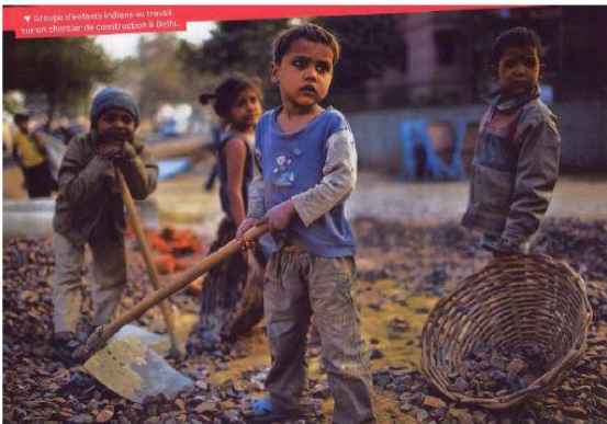
Groupes d'enfants indiens au travail sur un chantier de construction
