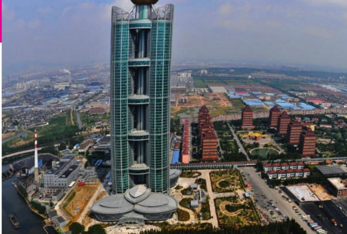
À l'est de la Chine, la localité de Huaxi, enrichie par la sidérurgie et le textile, a inauguré en 2011 cet hôtel cinq étoiles (avec piscine, spa, galerie marchande, restaurant tournant, etc.). Ce gratte-ciel, qui mesure quatre mètres de plus que la tour Eiffel, a coûté 360 millions d'euros et a fait de ce « village socialiste modèle » de 50 000 habitants l'un des symboles de l'époustouflante croissance chinoise.
